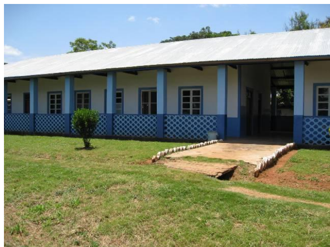
カリウアヘルスセンター：外科病棟外観
